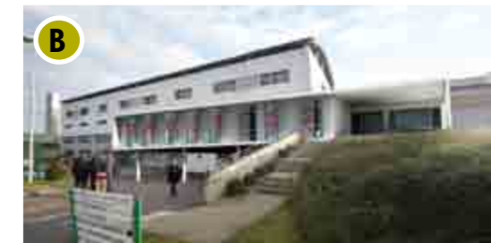
Ce chantier, d'une durée totale de 31 mois, représente un investissement de 29 millions d'euros.
