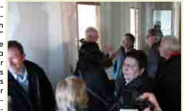
La réhabilitation du Centre Social Secondaire devrait recevoir une subvention du Département de Seine-Maritime. Cette visite de chantier a permis à Didier Marie et aux partenaires de ce projet d'en apprécier "de visu" le bon état d'avancement et la qualité.
