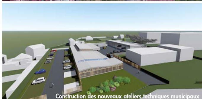
Construction des nouveaux ateliers techniques municipaux
