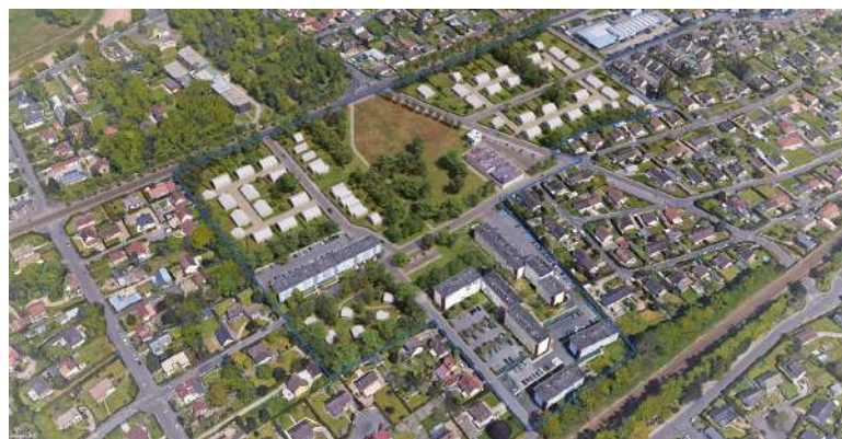
A l'horizon 2030. Démolitions, constructions, requalifications et résidentialisations feront émerger de nouveaux équipements, des espaces publics réaménagés, un plan de mobilité repensé et une offre d'habitat diversifiée (parc locatif réhabilité et habitat individuel en accession).
