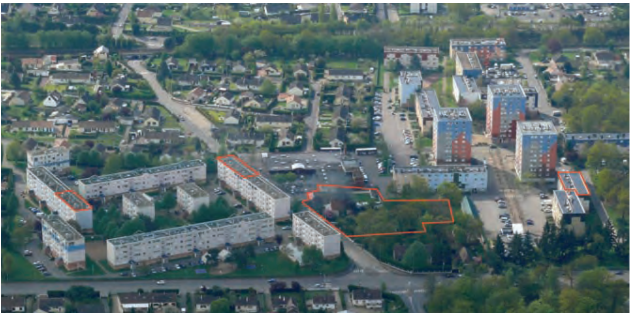
L'immeuble Dahlia, une partie des bâtiments A et C, la boulangerie et deux logements seraient touchés par le réaménagement. La requalification vise à recréer des espaces de vie moins denses et plus ouverts et à offrir des logements plus adaptés aux locataires de ces quartiers.
