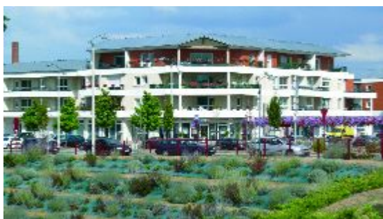
L'Espace des Foudriots : un lieu intéressant pour aborder les thèmes du passé industriel, de l'architecture, de l'activité commerciale ou encore, des services publics.
