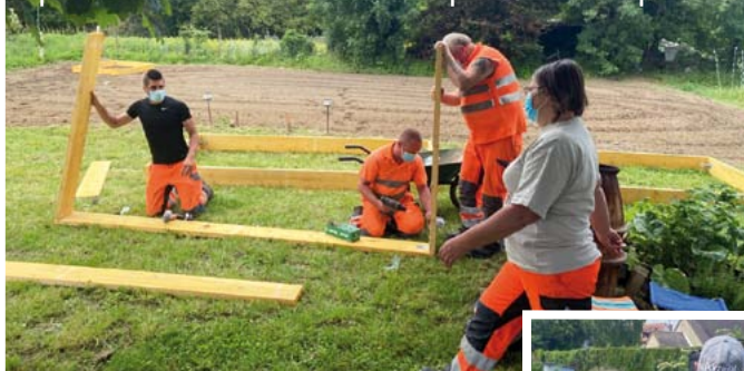
Préparation du terrain et construction des bacs par le service des espaces verts
