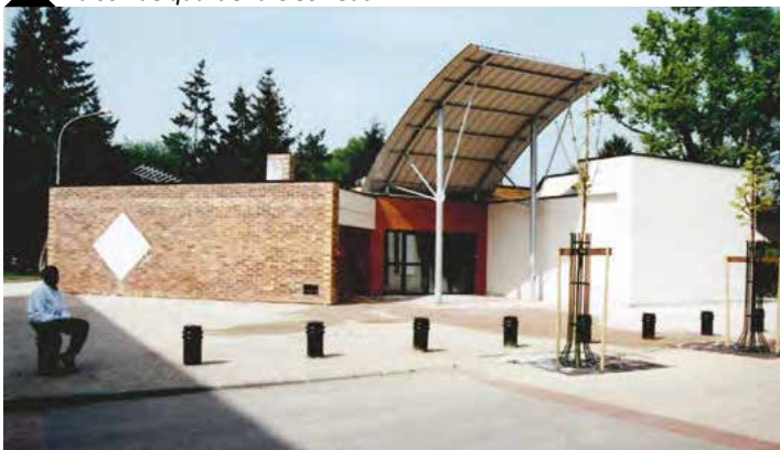
Maison de quartier à Cléon Sud
